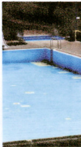
Das Nichtschwimmerbecken wird in den kommenden Wochen saniert.
